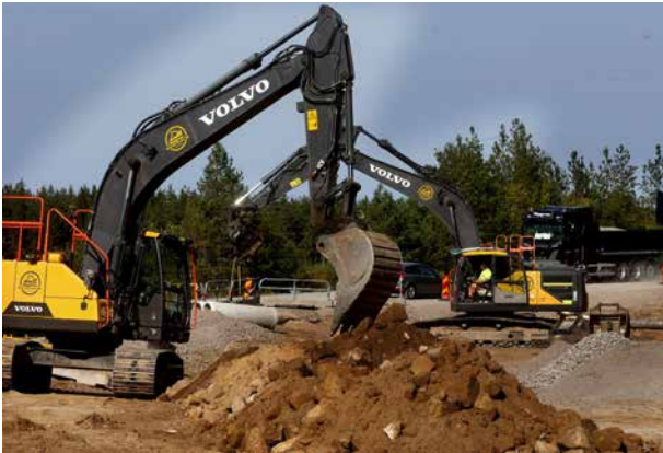
Det är riktigt stora maskiner som håller till vid Yggesbovägen i höst. Den ska breddas och nya infarter ska fram inför byggnationen av anstalten i Halltorp.
